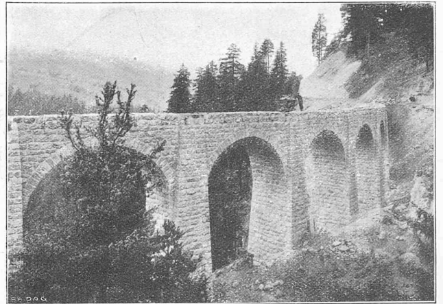
Fig. 15. — Le viaduc de Laxgraben.
