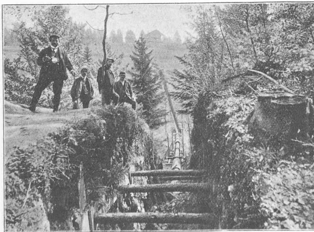
Fig. 4. — Vue de la fouille et de la conduite.
