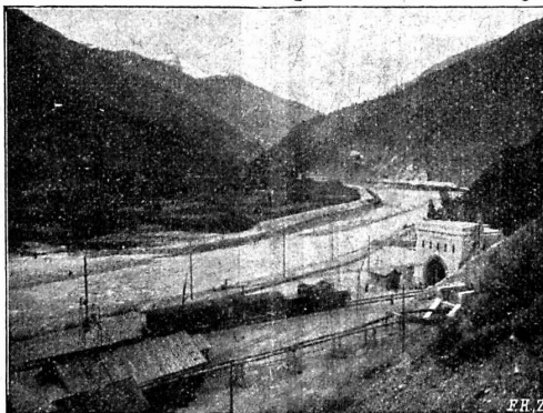
Portail Nord du Tunnel du Simplon.
