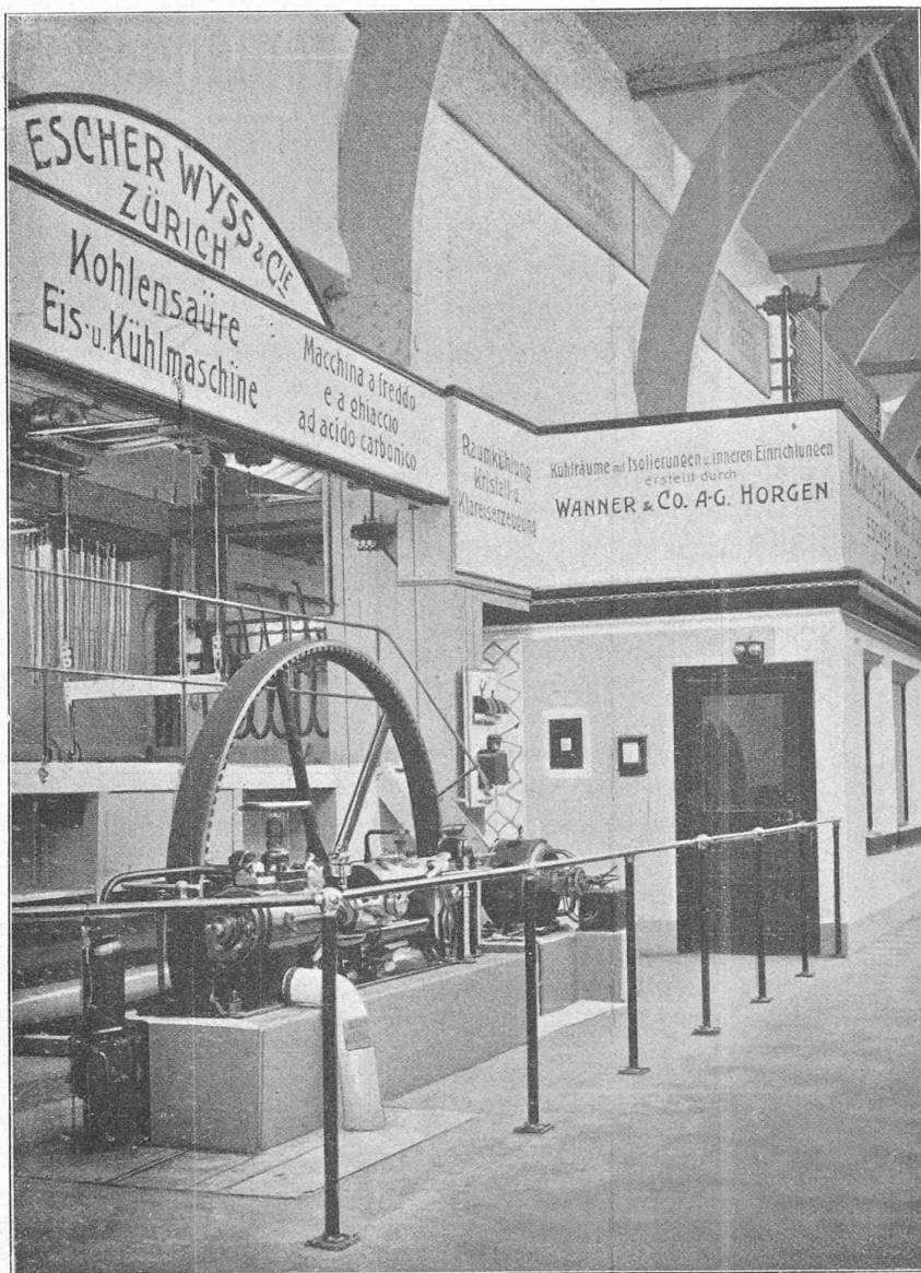
Fig. 27. — Station frigorifique de l'exposition collective des boucheries et charcuteries.
