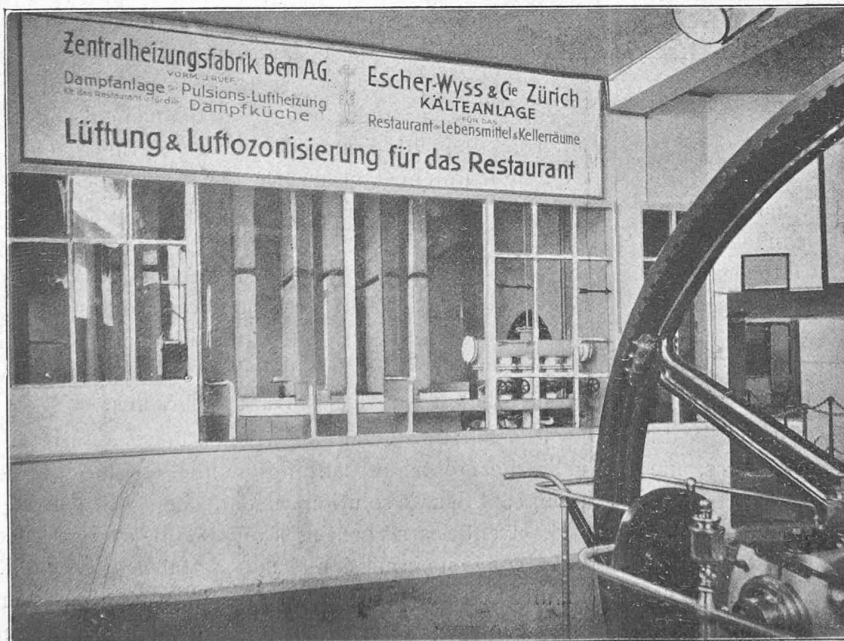
Fig. 26. — Vue du réfrigérant d'air formé par des radiateurs.
