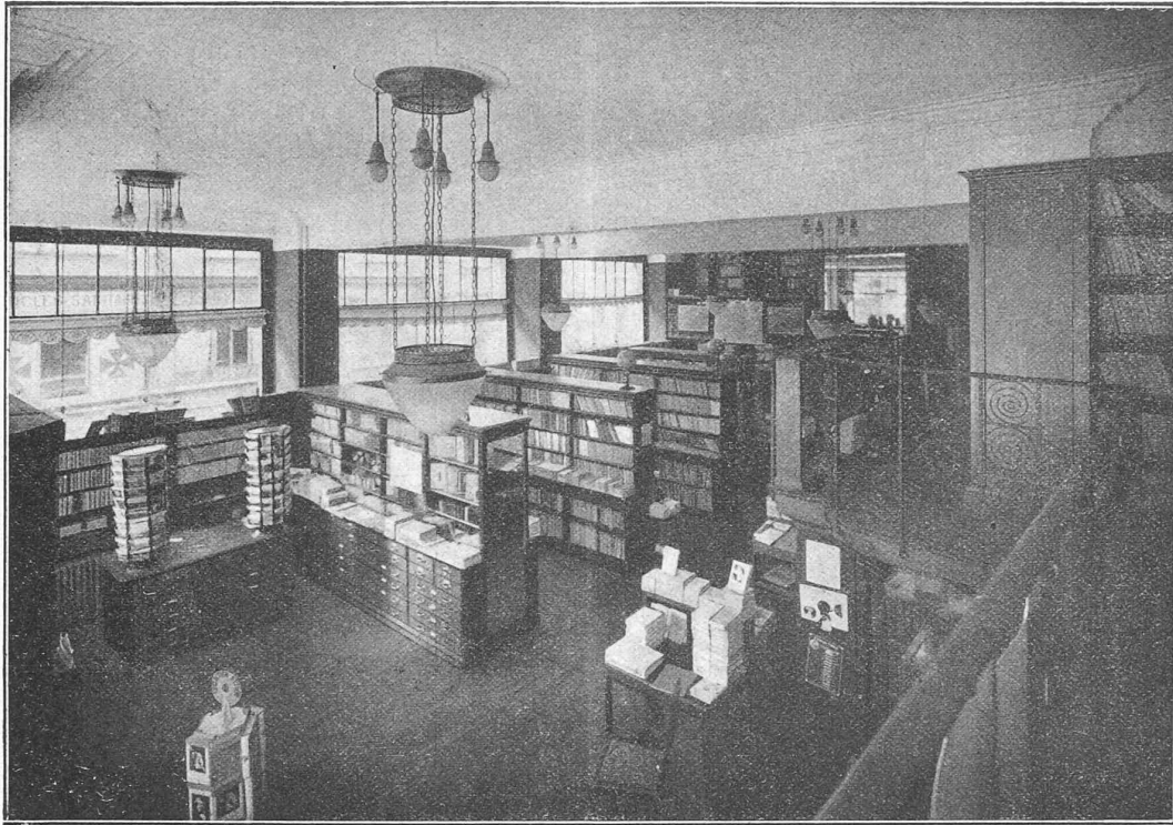
Rez-de-chaussée de la librairie Payot, à Lausanne.
