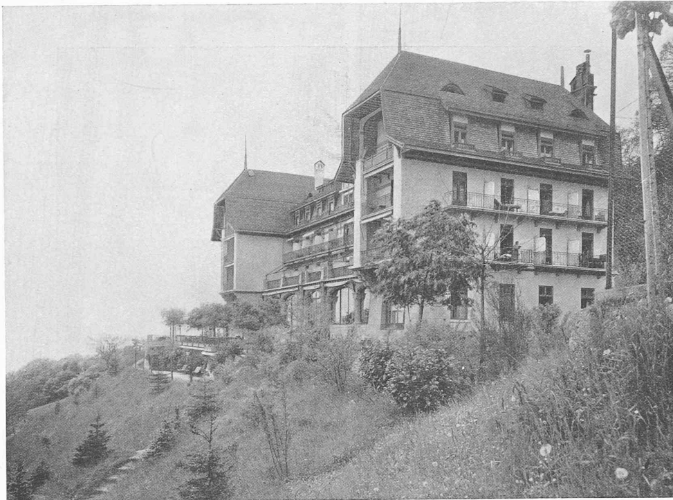
Vue des Façades Sud et Est.
