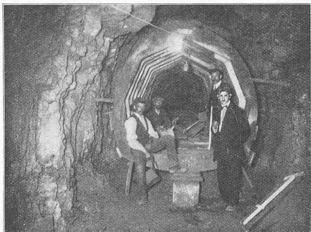
Fig. 10. — Coffrage de la galerie.
