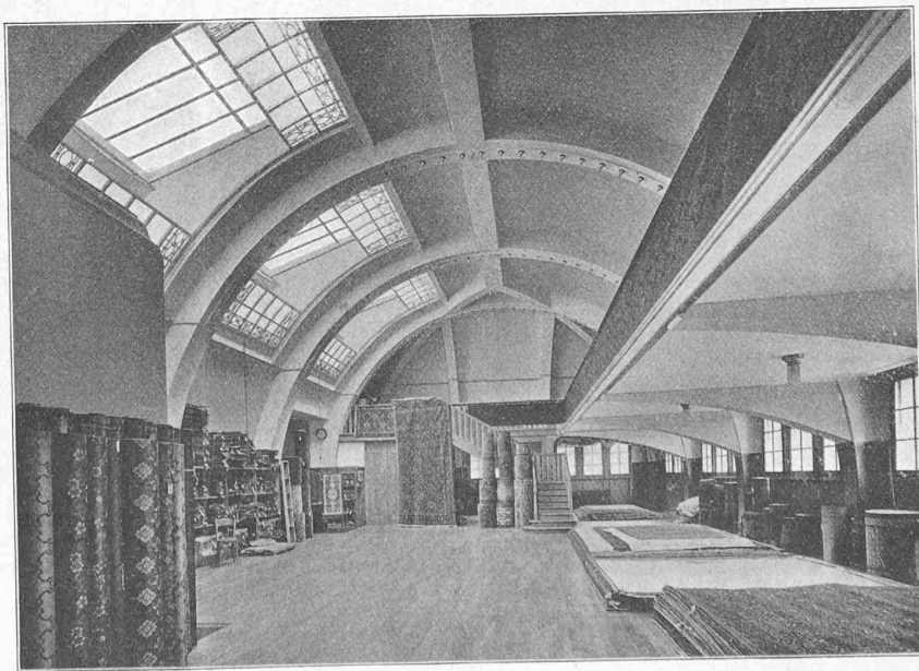
Fig. 21. — Vue intérieure de la toiture.
