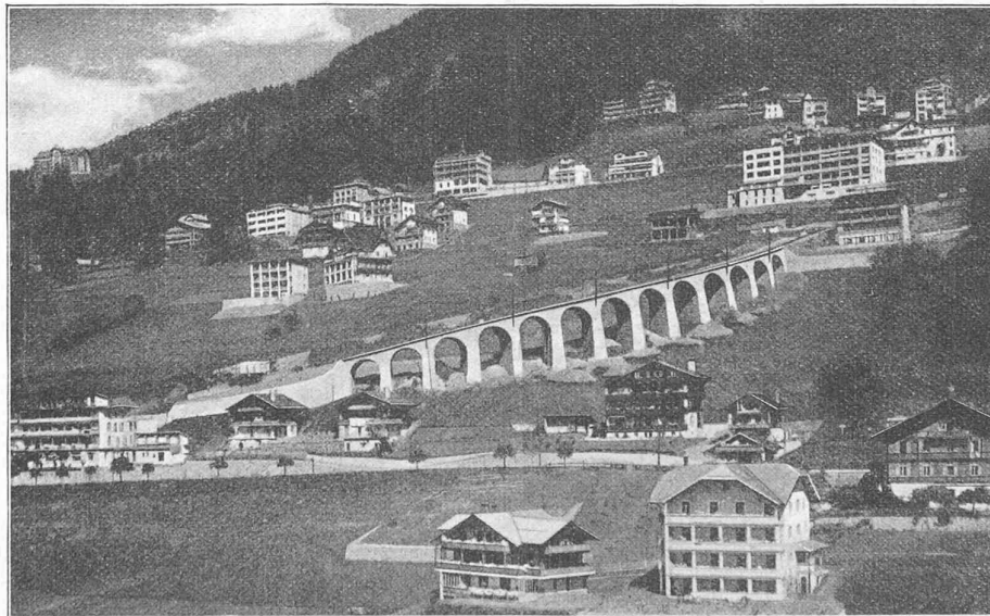
Fig. 1. — Vue du mur évidé.
