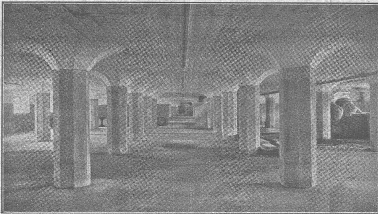
Plancher sans nervures, système Maillart. — Sous-sol d'entrepôt.
