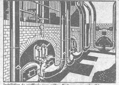
Installation de soufflerie sous grille « Foehn » pour combustibles pauvres
