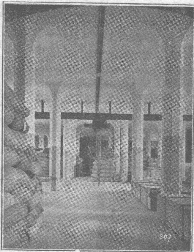
Rez-de-chaussée d'un Entrepôt, à Zurich
