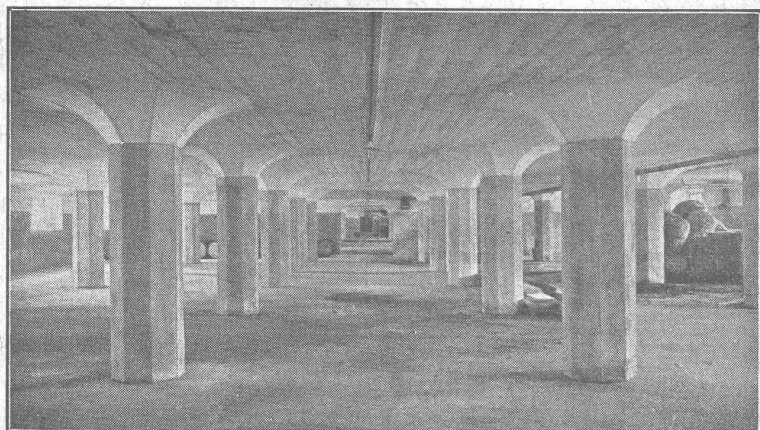
Plancher sans nervures, système Maillart. — Sous-sol d'entrepôt.
