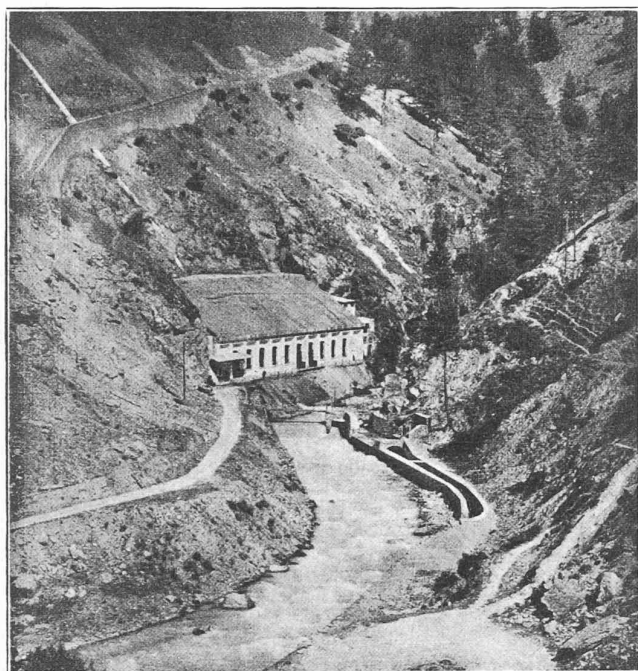
Fig. 10. — Partie de la conduite et bâtiment des machines de l'usine de Klösterli.
