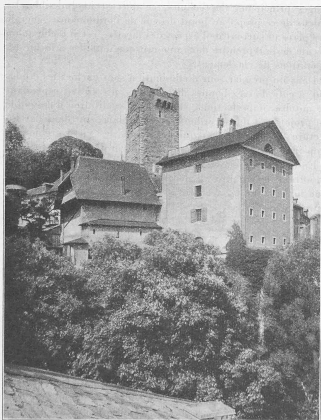
Fig. 3. — Vue de l'emplacement, prise du sud-ouest.
