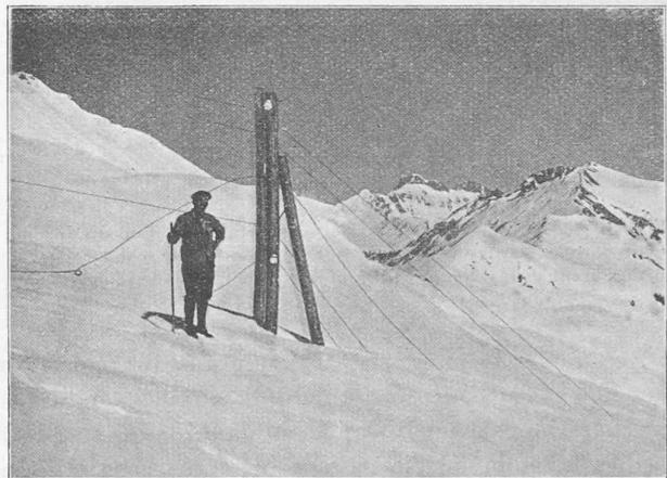
Fig. 2. — Le col des Andérets. Poteau de 12 m. Les 3 fils haute tension sont rompus, ainsi que les 2 fils téléphoniques. Le trait de lumière, à droite, en bas, marque le bord supérieur de la corniche.
