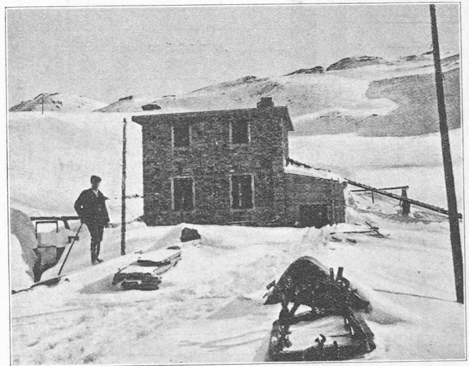
Fig. 22. — Station de pompage de Sorniot,
