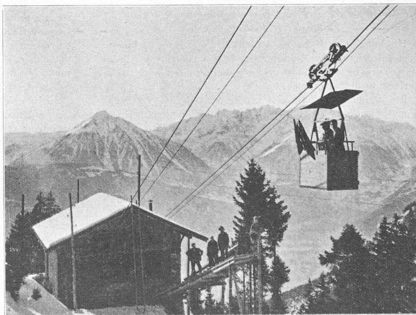
Fig. 29. — Câble aérien. Station inférieure.
