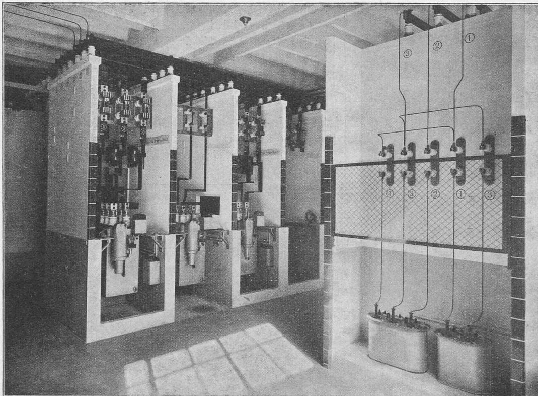
Fig. 38. — Appareillage du régulateur d'induction.
