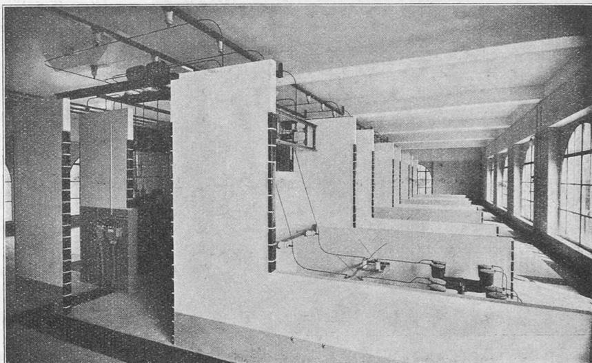
Fig. 40. — Appareils de protection des départs à 6000 v.
