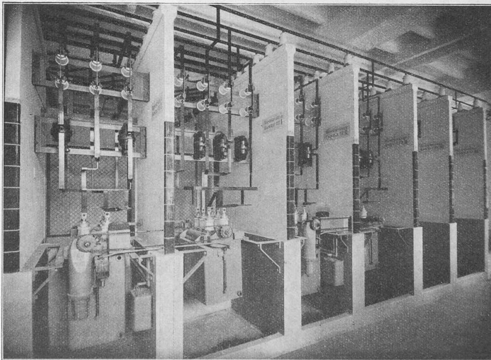
Fig. 39. — Interrupteurs des transformateurs de 800 kVA.
