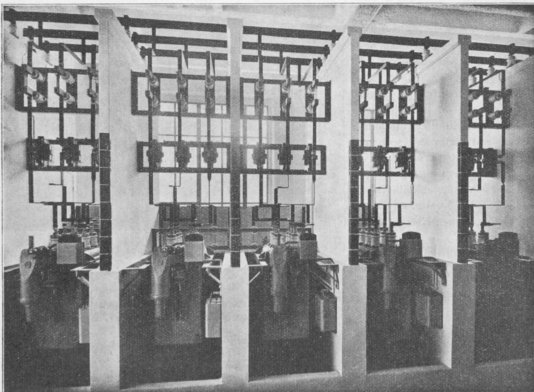
Fig. 41. — Interrupteurs des départs à 3000 v.
