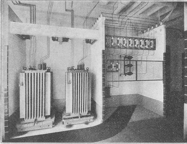
Fig. 42. — Transformateurs de 100 K V A.
