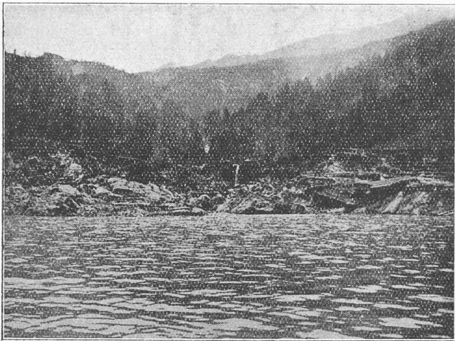
Fig. 52. — Affaissement de terrain et effets d'érosion à l'embouchure du « torrent du Chalet Vieux ». C'est en ce point que la berge sous-lacustre accusait la pente la plus douce.
