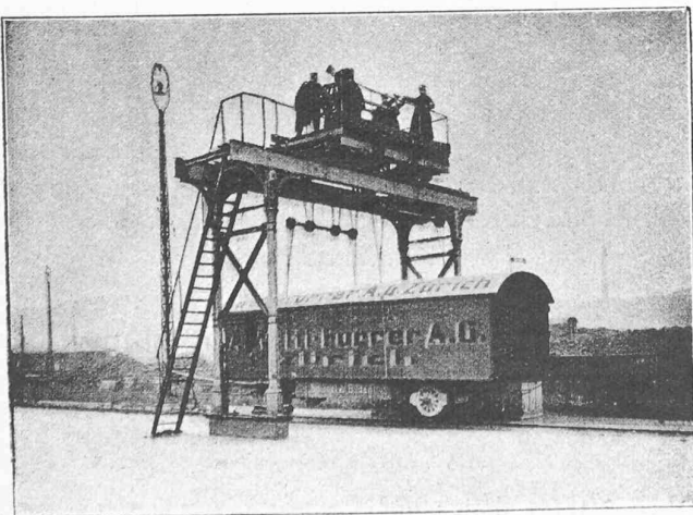
Fig. 1. — Ancienne installation, commandée à bras, de la gare de Zurich.
