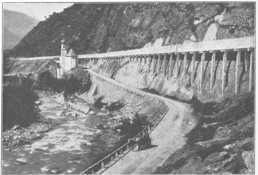
Fig. 2. — Aqueduc de Mœrel à Brigue.
