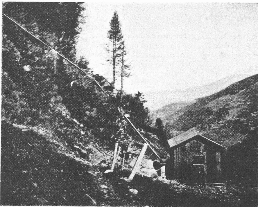
Fig. 1. — Conduite forcée en tubes de fer électrolytique *Bévé*.
