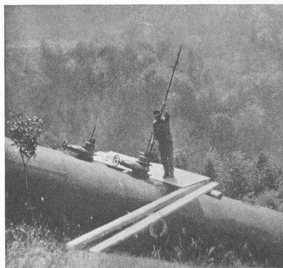
Fig. 3. — Station de jaugeage sur deux conduites forcées parallèles de 1801 mm. de diamètre intérieur.
