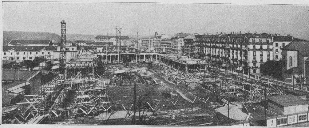
Etat des travaux le 3 mars 1926.
