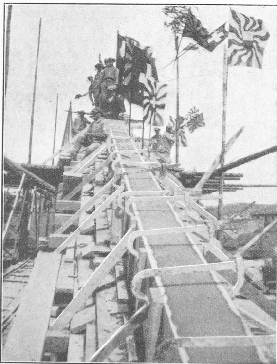
Fig. 12. — Terminaison du bétonnage des pignons.
