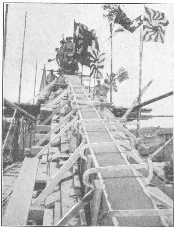
Fig. 12. — Terminaison du bétonnage des pignons.
