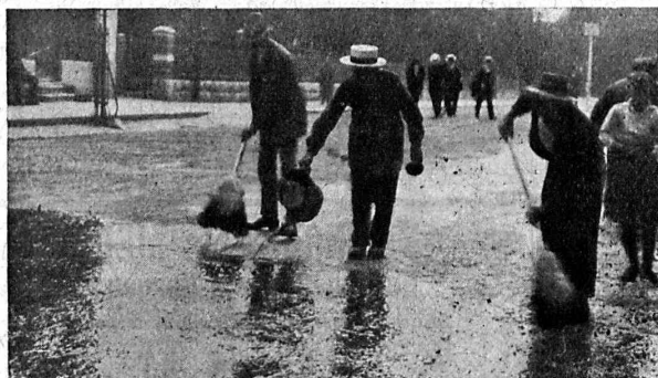
Bimoïdage d'une chaussée goudronnée
