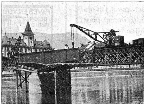
Grue pivotante, sur truck, à volée réglable, force 15 tonnes, utilisée à la réfection d'un pont.
