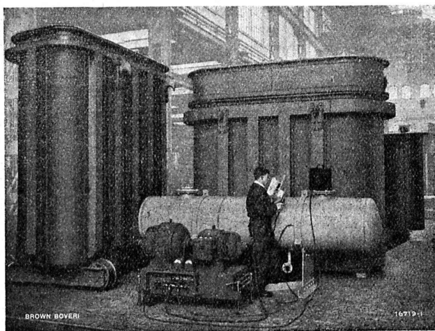
Cuves de transformateurs de grande puissance soudées électriquement à l'aide de groupes électrogènes construction Brown-Boveri.
