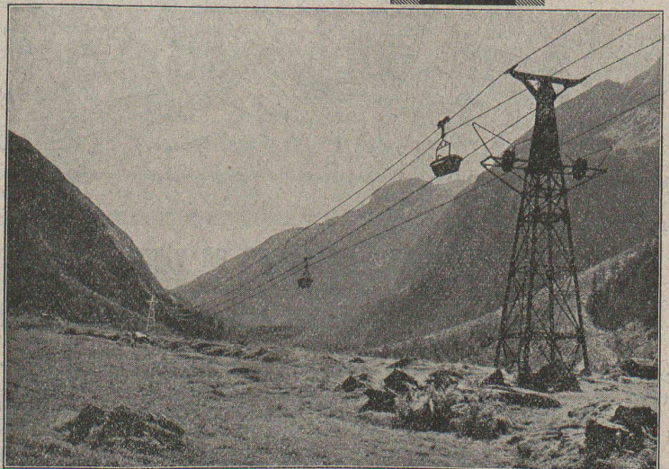
Chemin aérien pour le transport du matériel de construction pour l'établissement du barrage du Grimsel.
