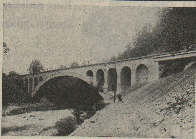
Pont amont C. F. F. du „Kessiloch“.
