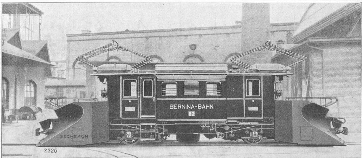
Fig. 1. — Locomotive à courant continu, type AA-AA N° 82, du chemin de fer de la Bernina.
