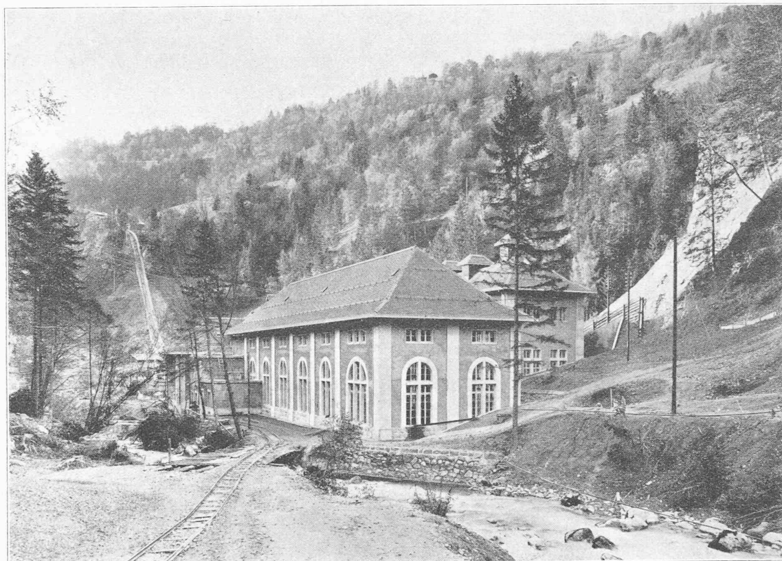
Fig. 16. — Usine génératrice de la Peuffeyre. Vue sud-est.
