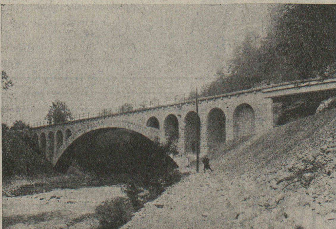
Pont amont C. F. F. du „Kessiloch”.
