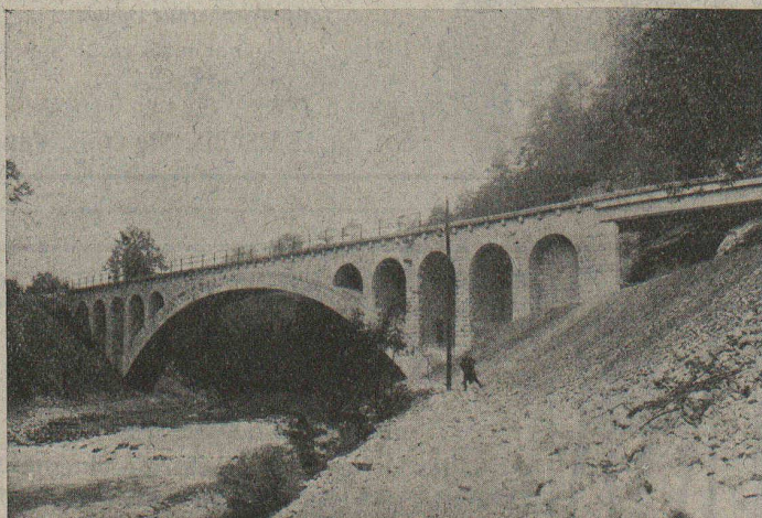
Pont amont C. F. F. du „Kessiloch”.
