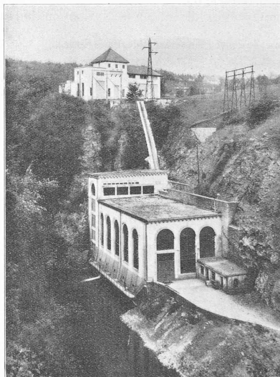
Fig. 5. — Usine et Poste de Montcherand. Côté arrivée de la ligne à 120 kV.
