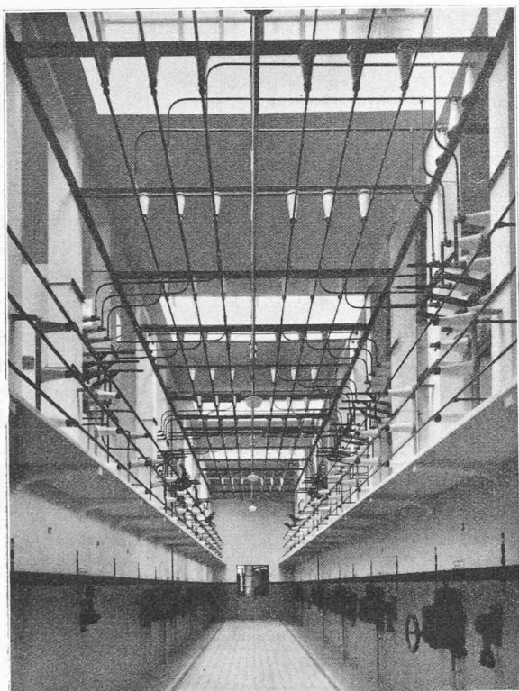
Fig. 12. — Poste de Montcherand. Vue du couloir central.
