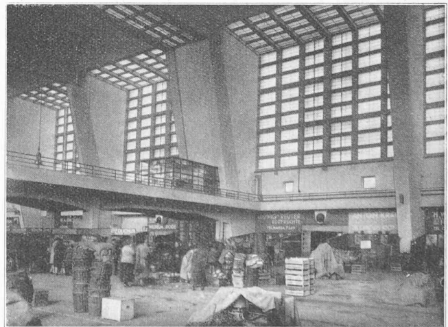
Fig. 5 et 6. — Vues de l'intérieur de la grande halle.
