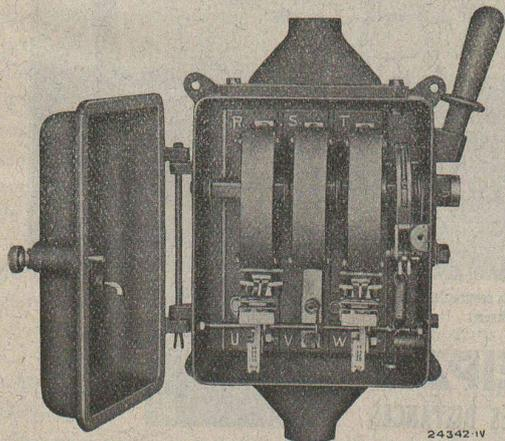
Le nouveau coffret de manœuvre type LC, avec déclencheur thermique est la meilleure protection des moteurs contre un échauffement nuisible causé par le courant, d'où peu de réparations, surveillance réduite, fonctionnement économique.
