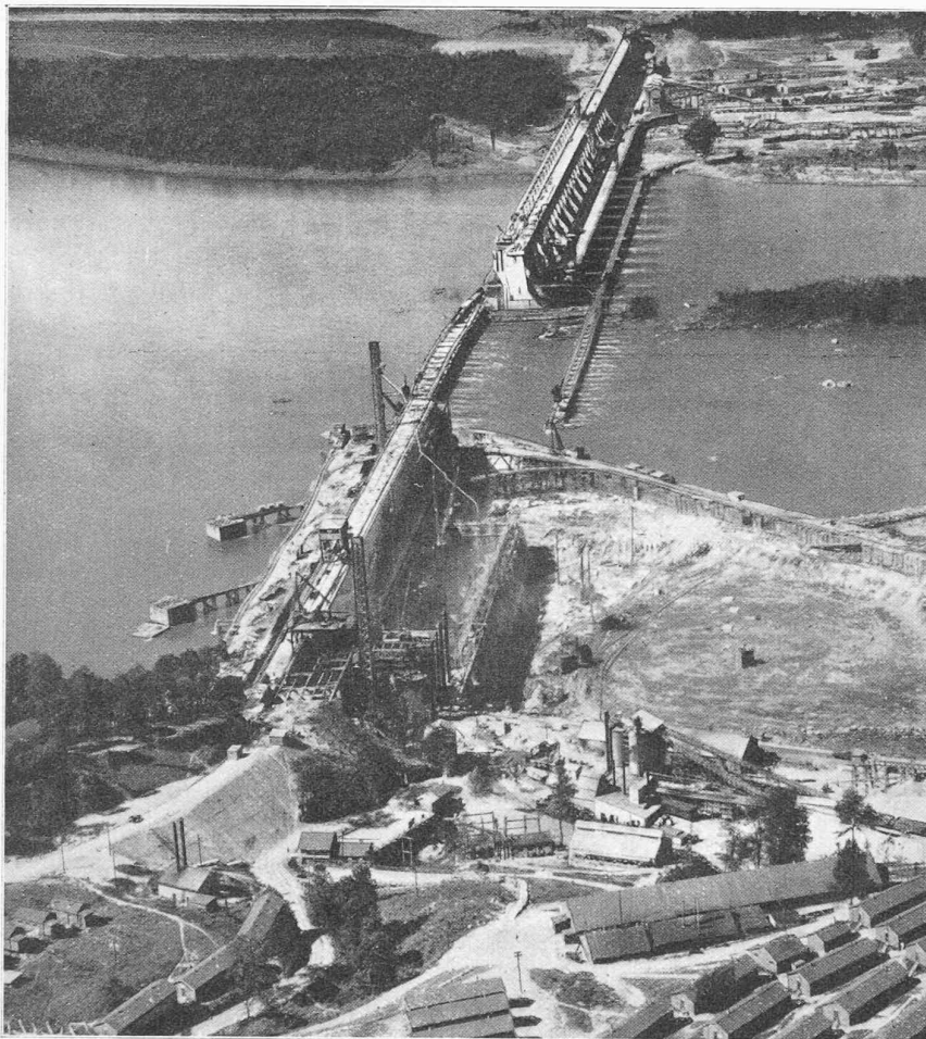
Fig. 2. — Vue aérienne du barrage de Conowingo en construction.
