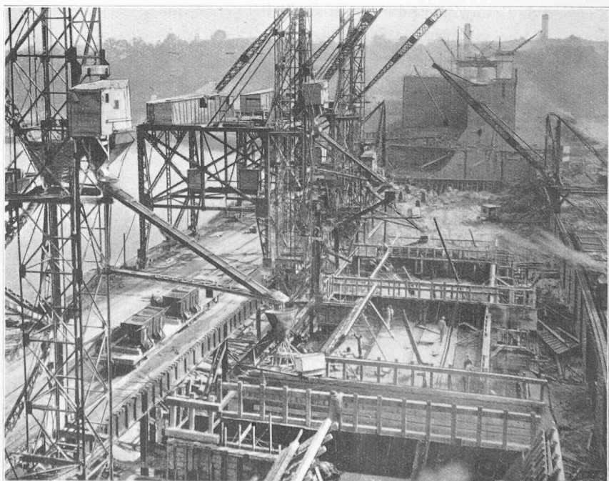
Fig. 3. — Construction du barrage de Conowingo.
