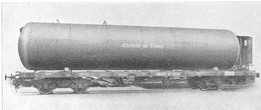
Fig. 4. — Un des réservoirs (100 m<sup>3</sup>; pression du gaz 5 atm.) de la station de Champ-Bougin.
