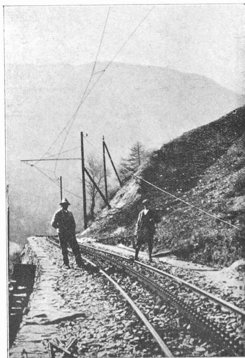
Fig. 5. — Raccordement du fil de contact en courbe.
