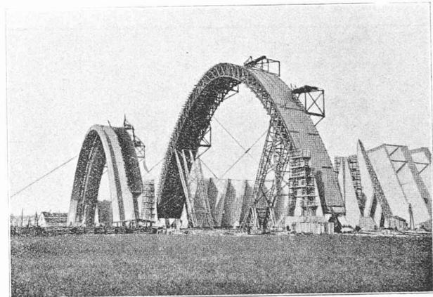
Fig. 8. — Construction de la deuxième onde du premier hangar et achèvement du cintre du deuxième hangar.
