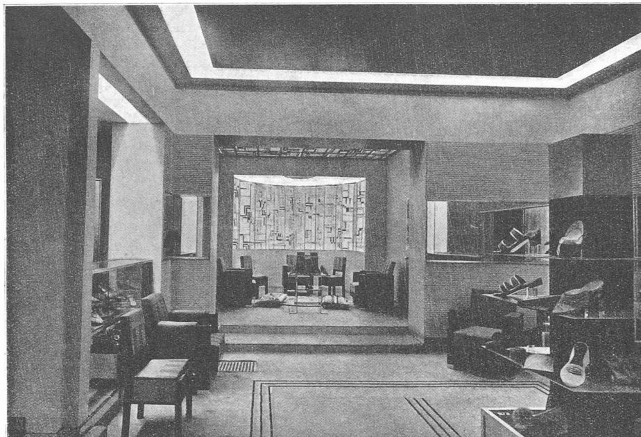
Fig. 1. — Vue générale du magasin de luxe de la « Société commerciale des chaussures Bally », à Paris, 11, boulevard de la Madeleine.
