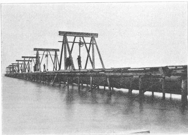
Fig. 22. — Descente de la conduite immergée.
