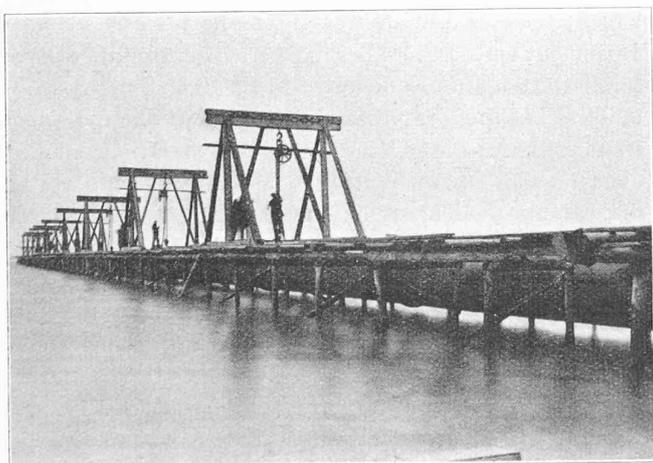
Fig. 22. — Descente de la conduite immergée.
