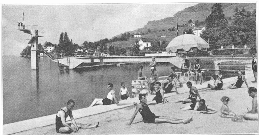
Fig. 5. — Vue du plongoir et de la passerelle
