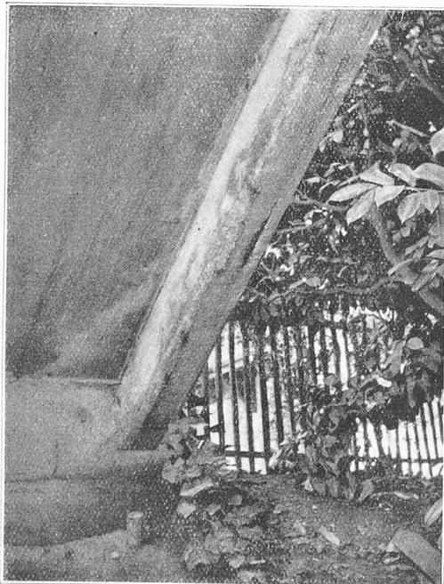
Fig. 14. — Partie d'une passerelle fissurée.
