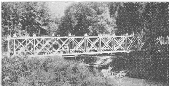
Fig. 11. — Pont système Eiffel , de 30 m, montage d'essai militaire (en Autriche).
