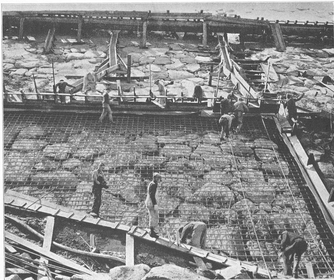
Fig. 10. — Vue de l'armature du masque. Le béton est coulé sur les blocs de rocher mis en place par le derrick. Chaque panneau de 18,29 m × 18,29 m est fait d'une seule coulée.
